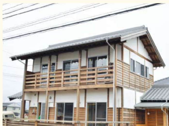
木の優しさ、暖かさを外観からも見てとれる。また床を高くし床下の換気をちゃんととってあるので、シロアリの心配もない。
